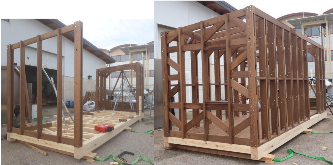
Fotos: Pasos obtenidos en diferentes fases de la fabricación y montaje de la estructura realizada a partir de madera termotratada de pino silvestre.
